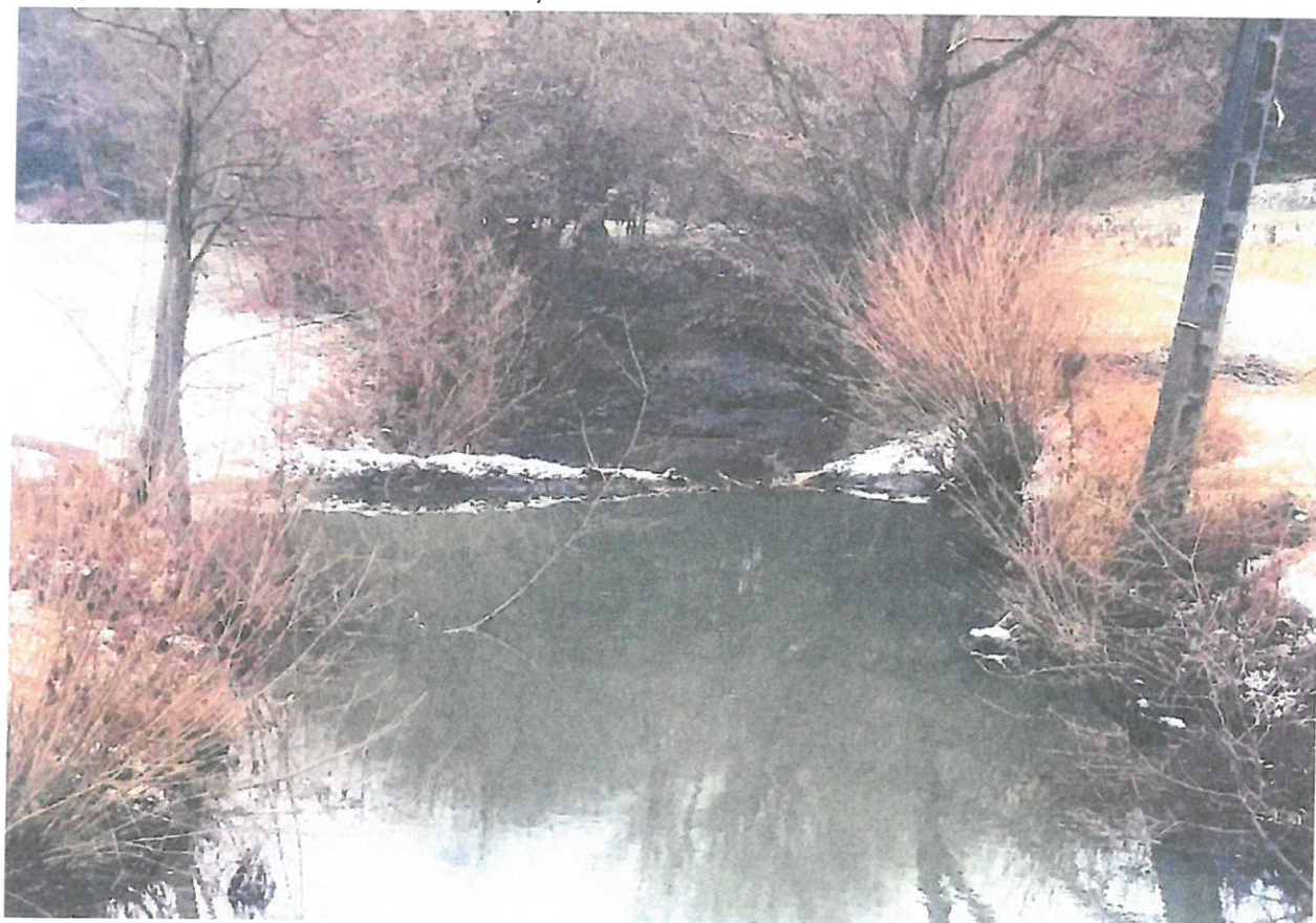
Fotografia nr 18 – Rozbiórka tam bobrowych
