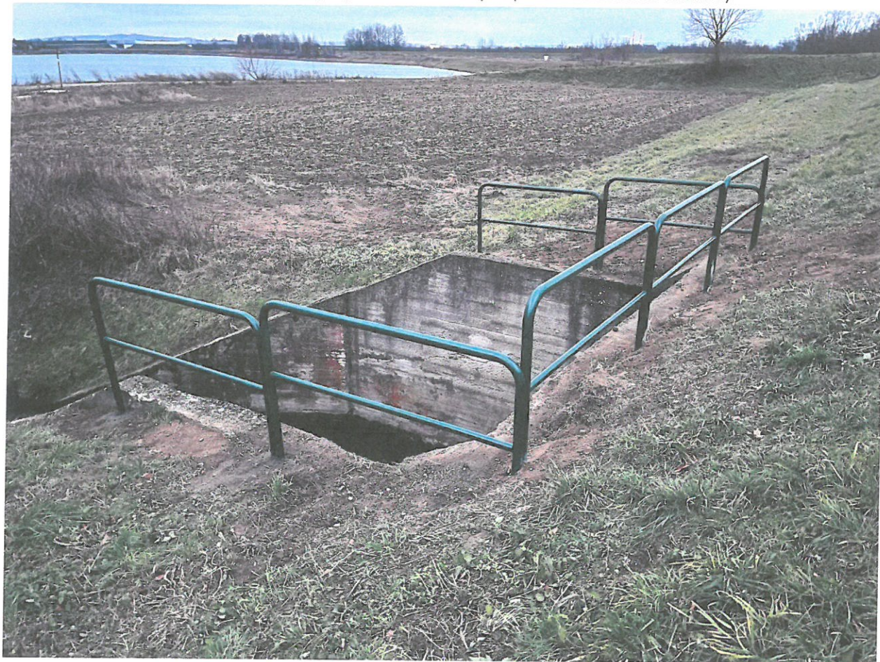
Fotografia nr 17 - Naprawa barierek przy śluzach wałowych (msc. Bobrowniki Wielkie)
