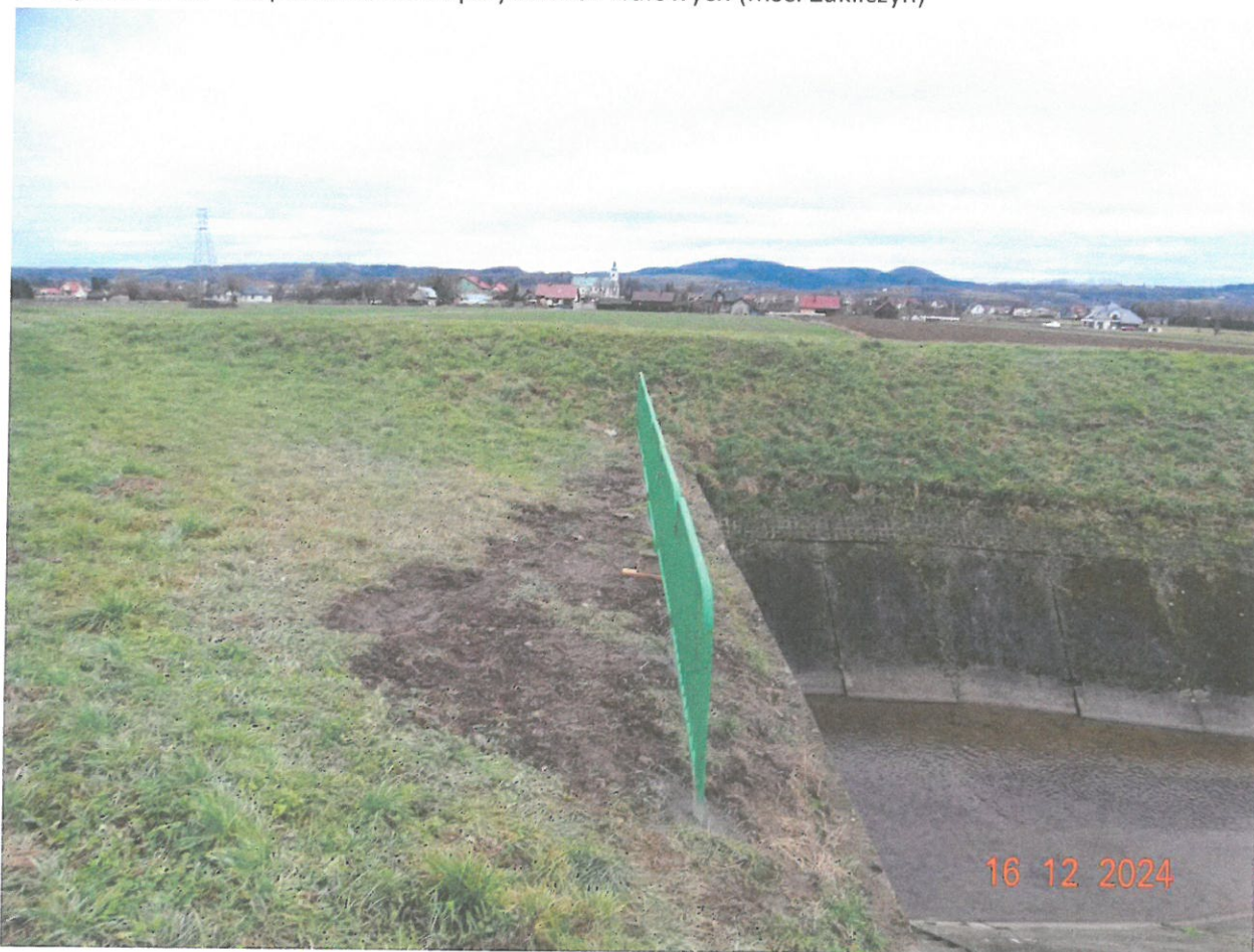
Fotografia nr 16 - Naprawa barierek przy śluzach wałowych (msc. Głów)
