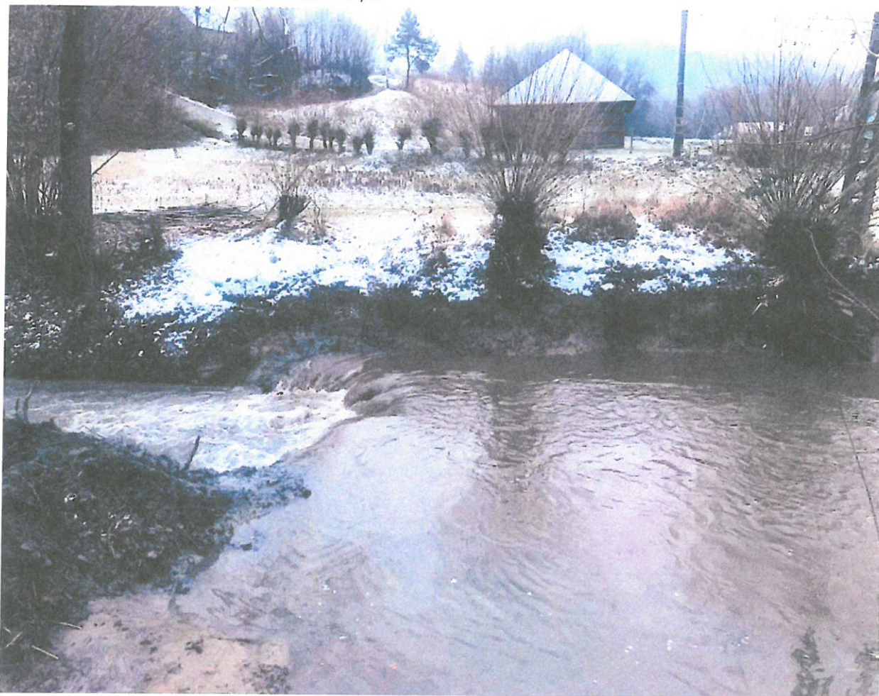
Fotografia nr 20 – Konserwacja i utrzymanie obwałowań
