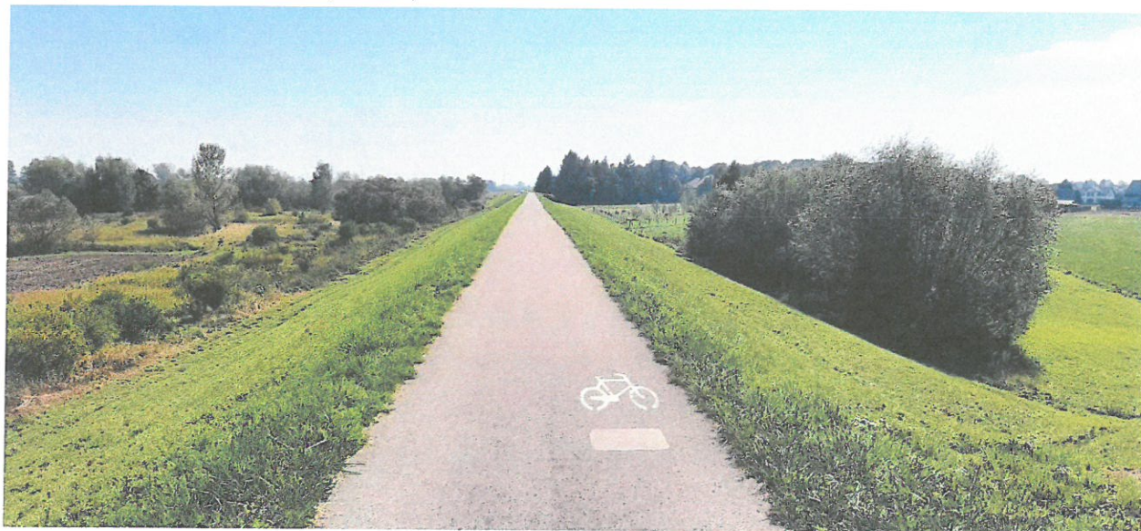
Fotografia nr 21 – Konserwacja i utrzymanie obwałowań
