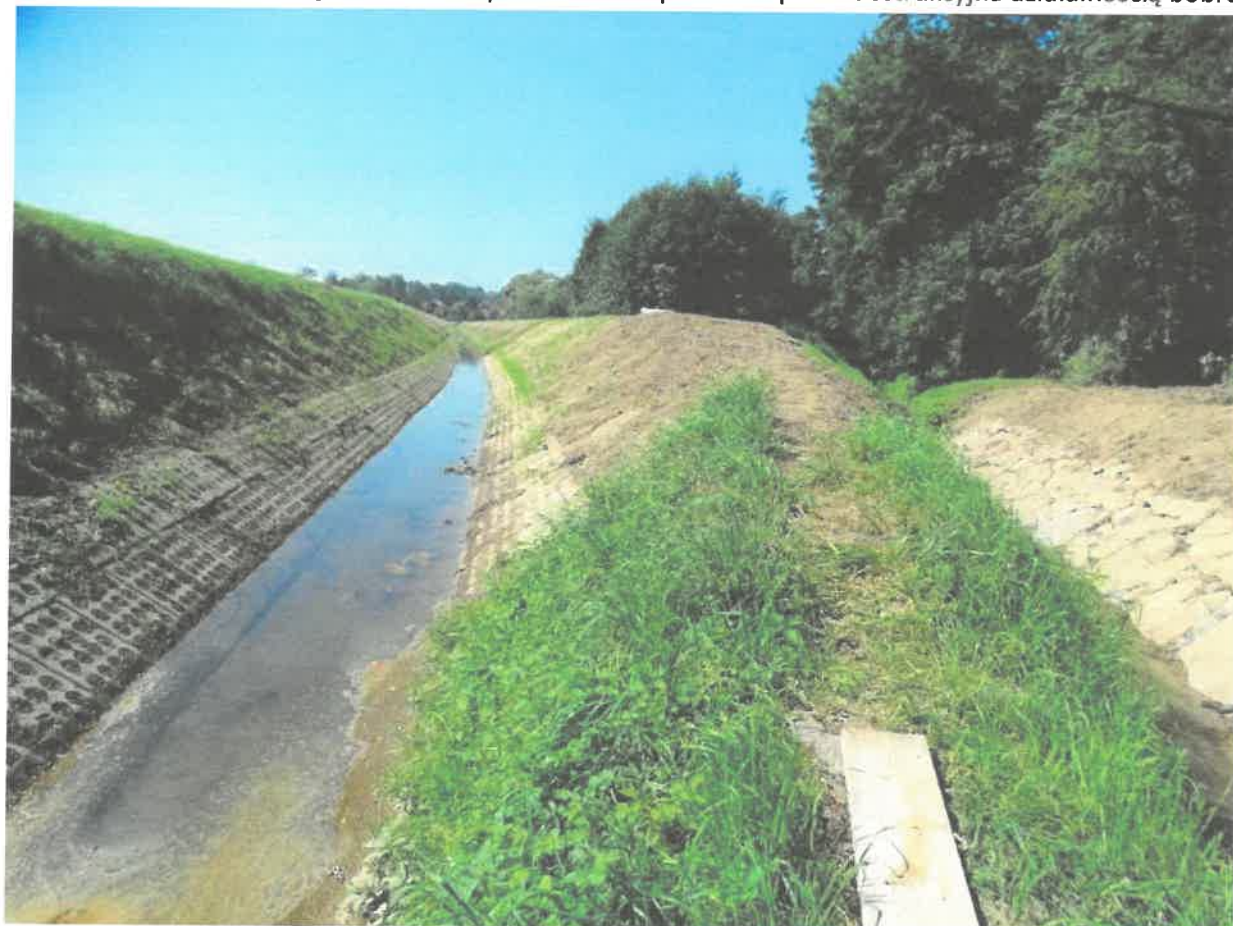
Fotografia nr 8 - Likwidacja nor bobrowych oraz zabezpieczenie przed destrukcyjną działalnością bobrów
