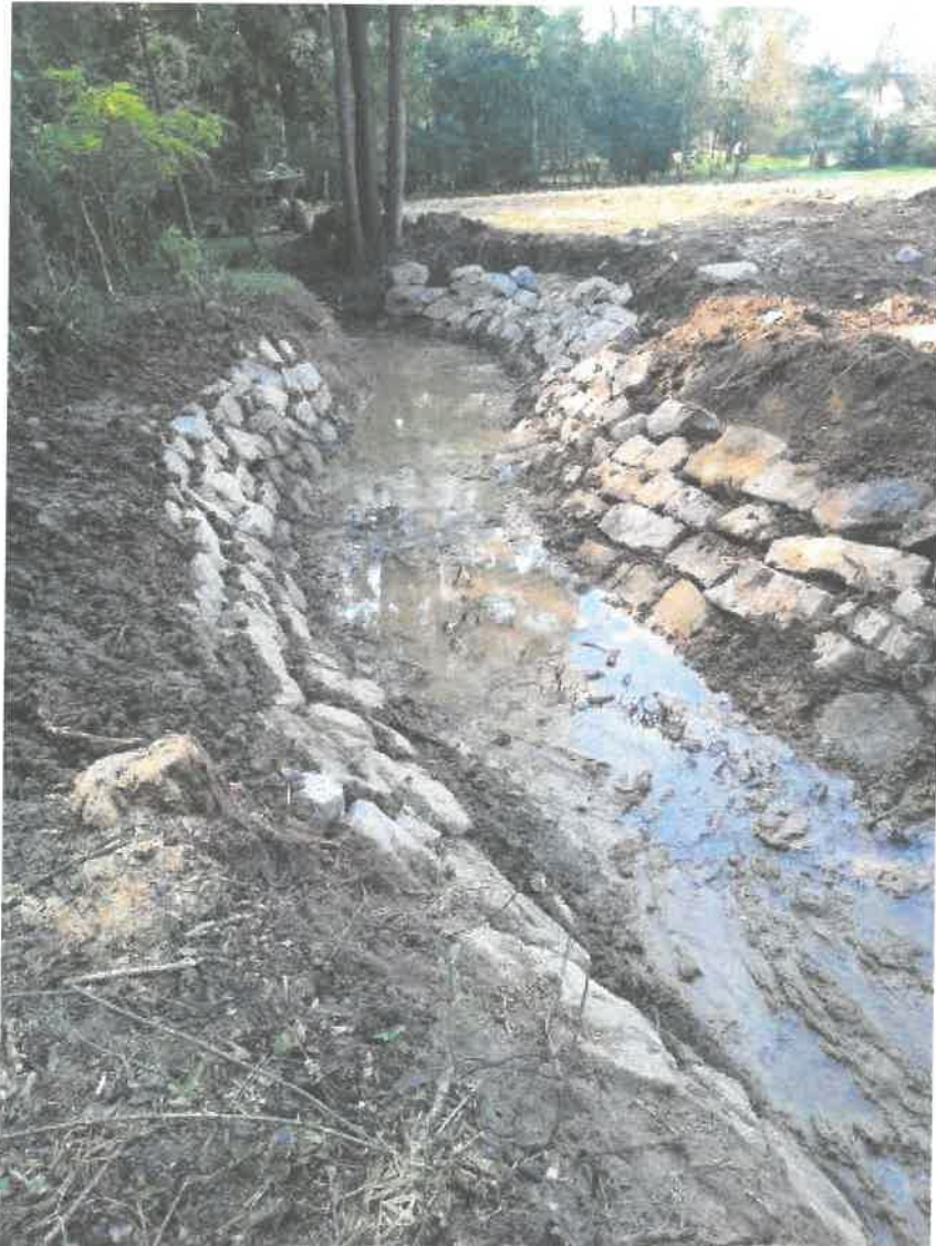
Fotografia nr 14 - Potok Skarpa w km 1+600 – 1+760
